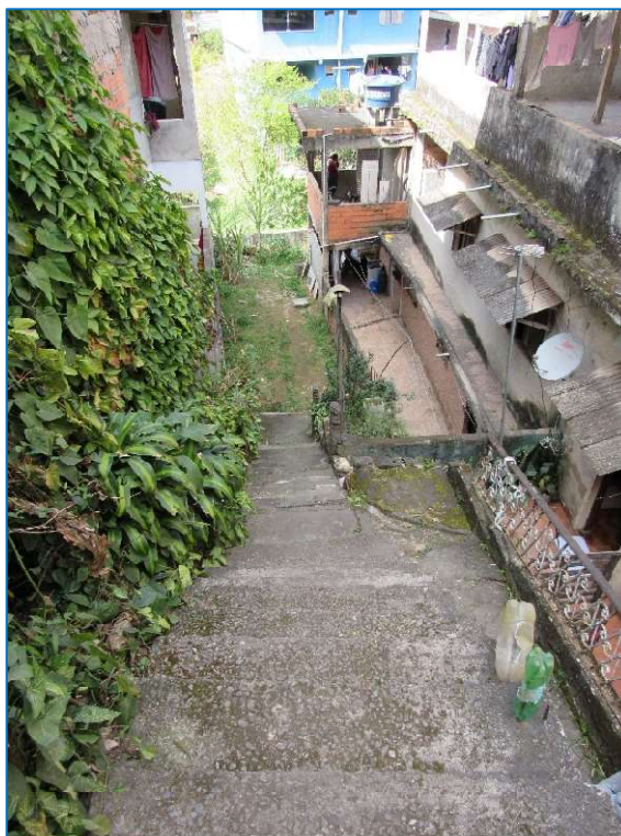
ESCADA DE ACESSO AO 2º PAVIMENTO INTERIOR.
