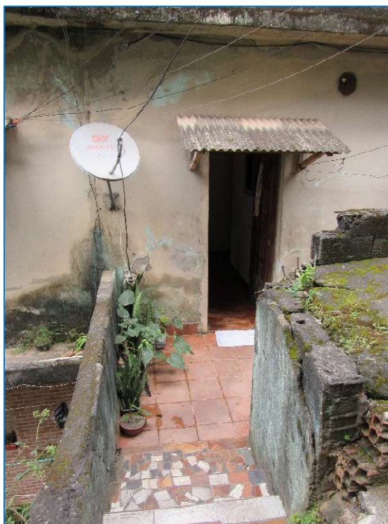
ÁREA DE ACESSO À CASA 2.
