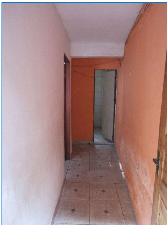
HALL DE ENTRADA / CIRCULAÇÃO.
