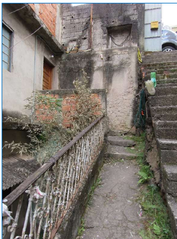
ÁREA DE ACESSO À CASA 3.
