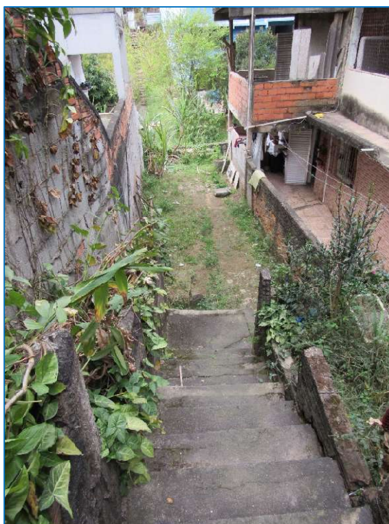
ESCADA DE ACESSO AO 3º PAVIMENTO INFERIOR.
