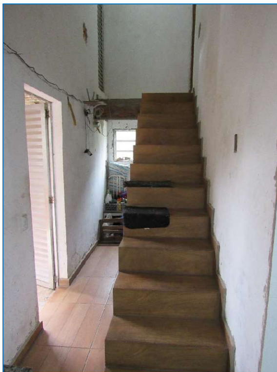
ESCADA DE ACESSO AO 2º ANDAR DA CASA 1.
