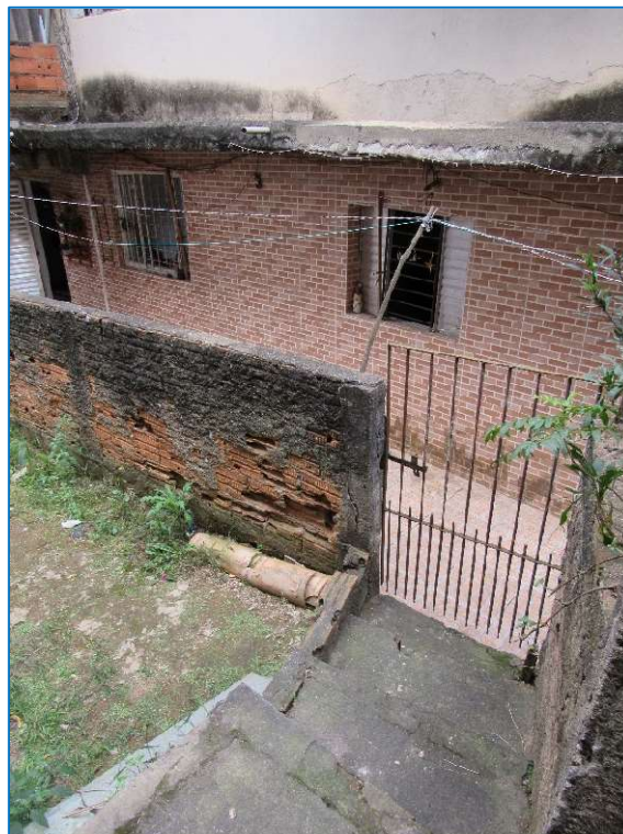
ÁREA DE ACESSO À CASA 1.
