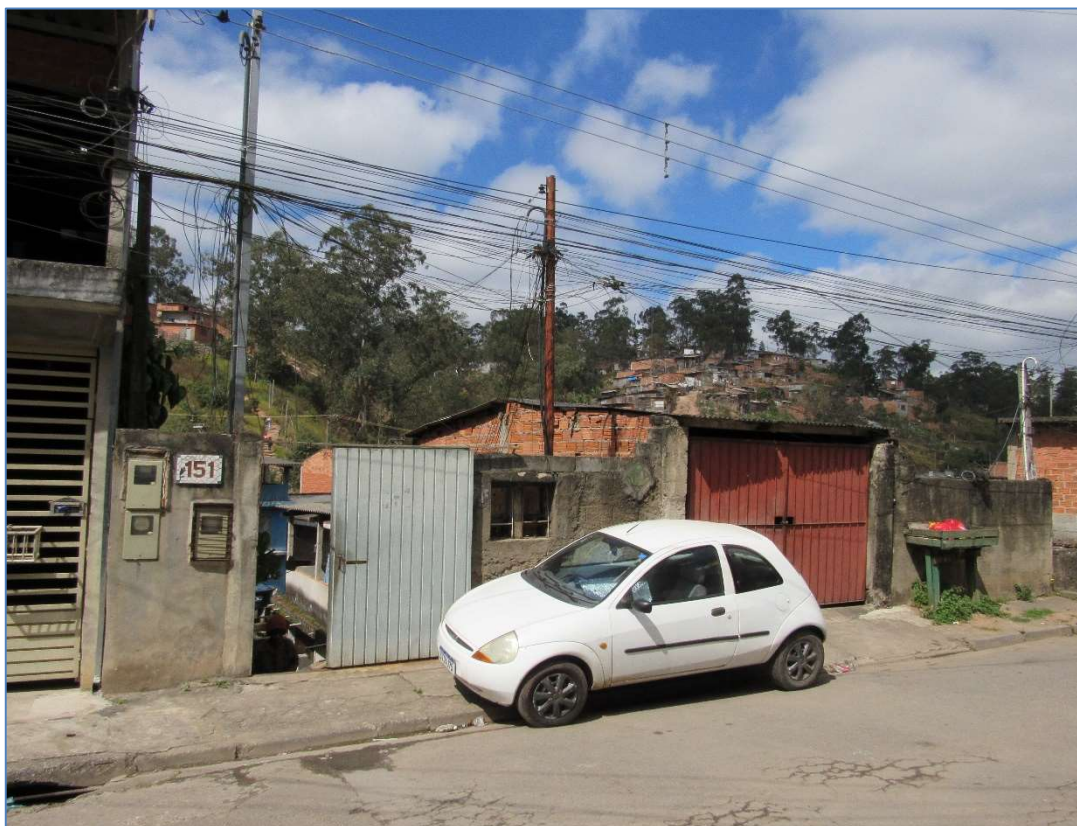
FACHADA DO IMÓVEL AVALIANDO.
