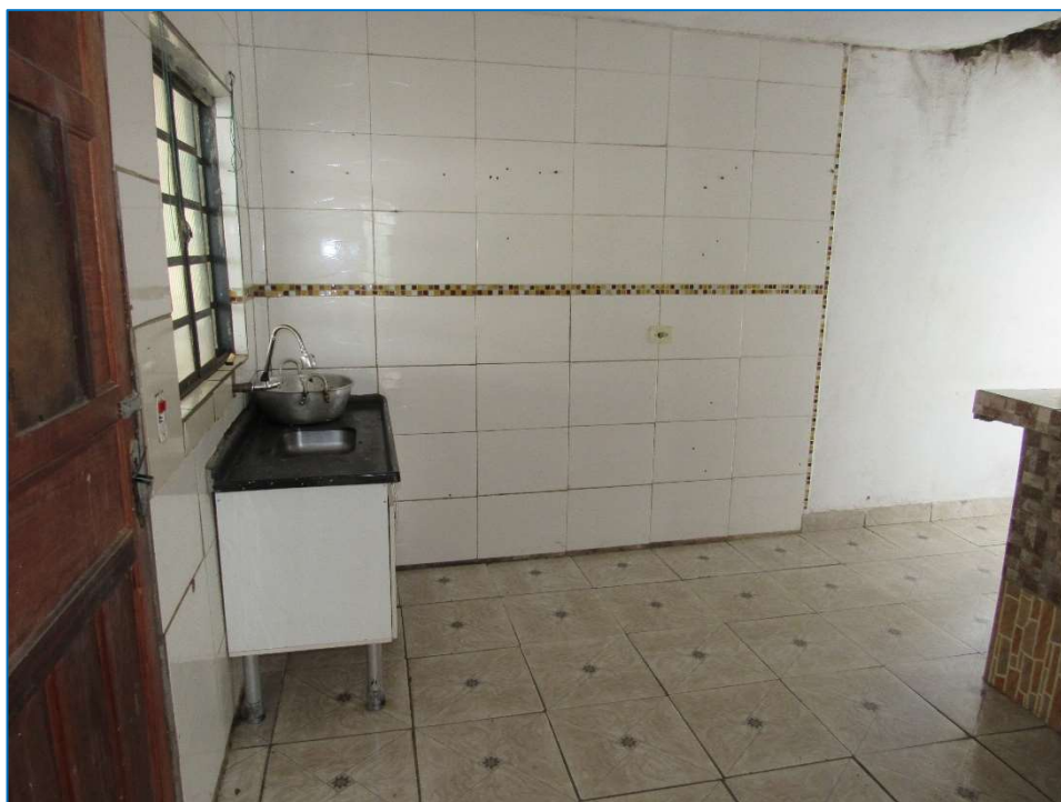
OUTRA VISTA DA COZINHA.
