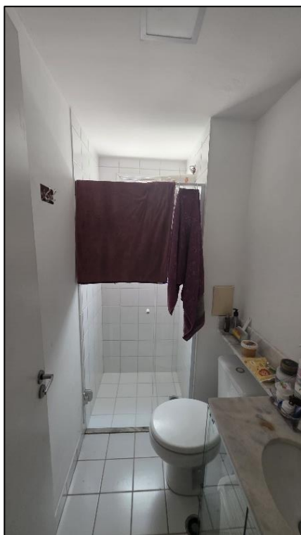
Imagem 17: Banheiro com piso e paredes do box revestidos em cerâmica, demais paredes e laje com pintura sobre reboco.
