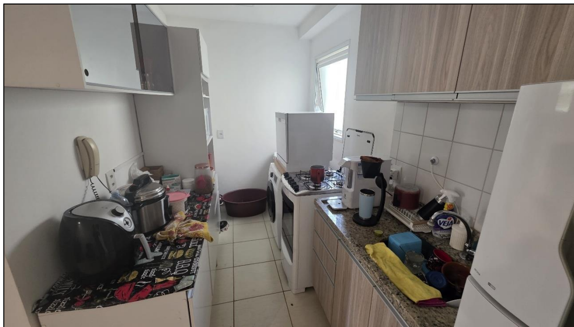
Imagem 14: Cozinha do imóvel com revestimento cerâmico no piso e parcialmente aplicado nas paredes.
