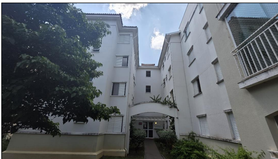
Imagem 09: Vista geral para o condomínio e para o bloco 03 onde está localizada a unidade periciada.
