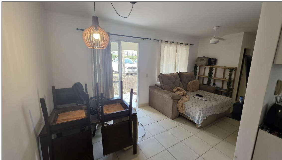
Imagem 12: Sala de estar e TV com piso cerâmico, paredes e laje com reboco e pintura.
