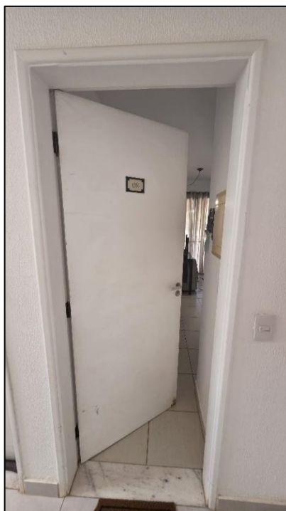
Imagem 11: Porta de acesso ao imóvel vistoriado (Apartamento n.º 08).
