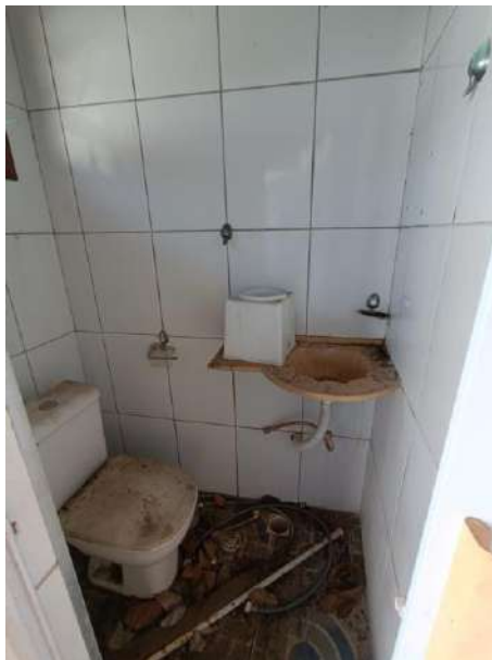
Foto 22 - BANHEIRO ÁREA DE PISCINA
