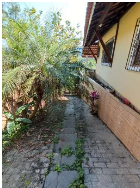
Foto 03 - RAMPA DE ACESSO
