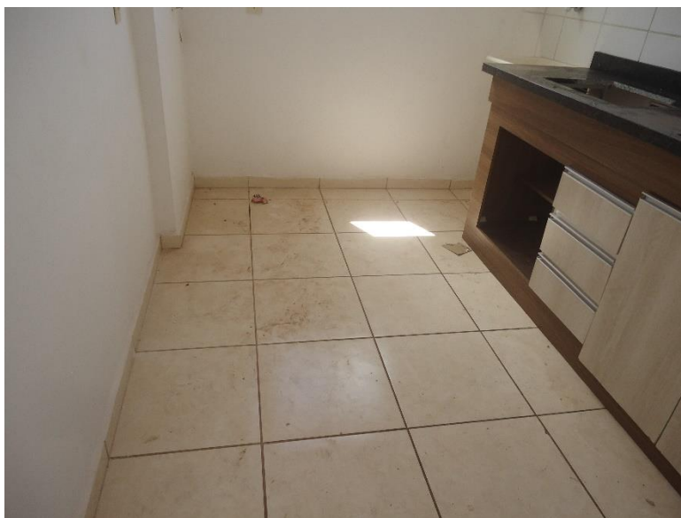
Cozinha/área serviço – piso cerâmico.
