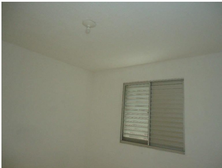
Quarto lado esquerdo: forro laje, paredes com pintura.
