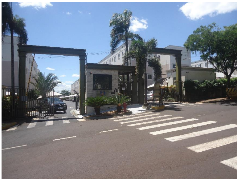
Portaria vista pelo lado externo.
