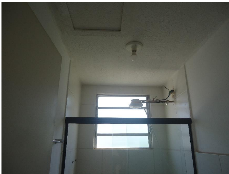
Banheiro: paredes parte azulejos.
