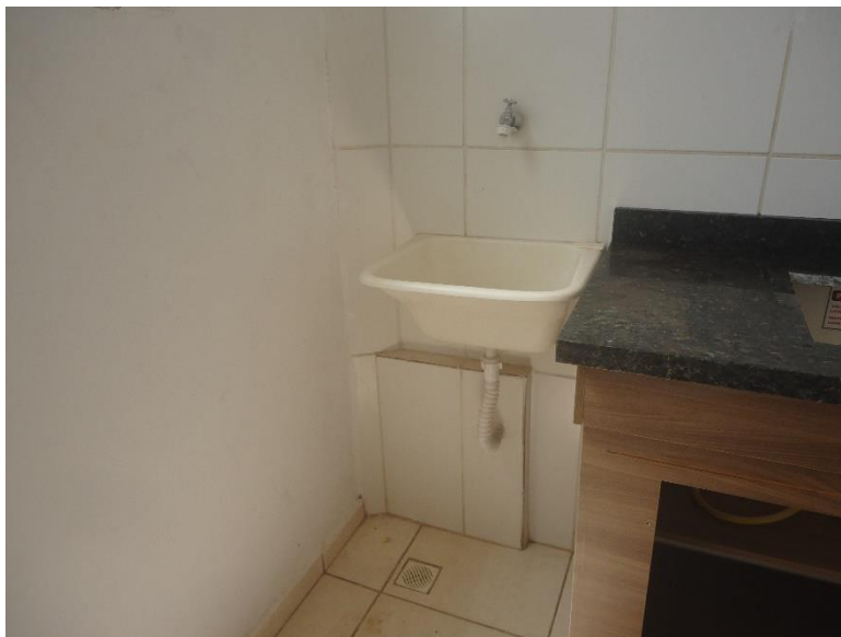
Área serviço – tanque, paredes parte azulejos.
