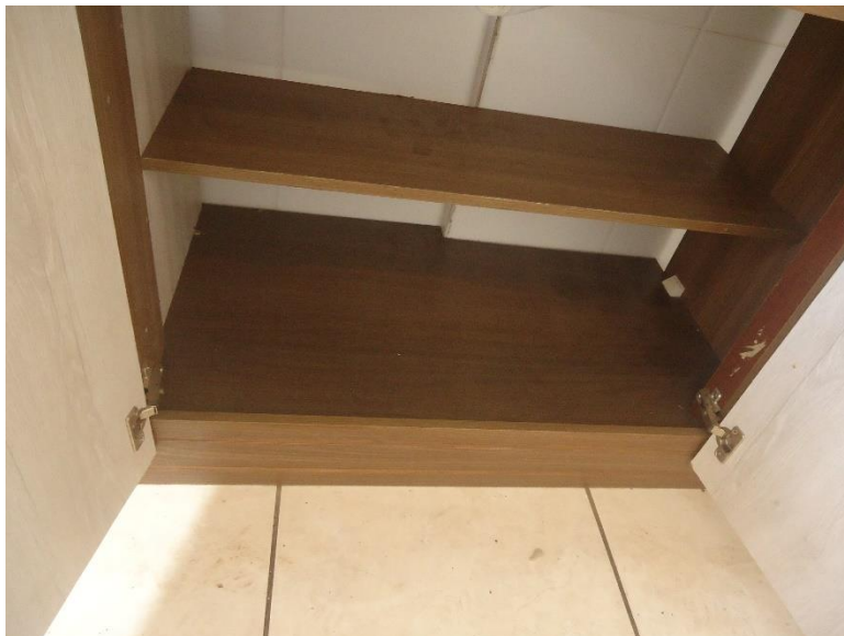
Armário sob a pia da cozinha.
