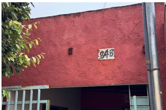
Foto 07: FACHADA DO IMÓVEL
