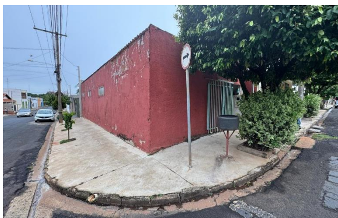
Foto 06: FACHADA DO IMÓVEL
