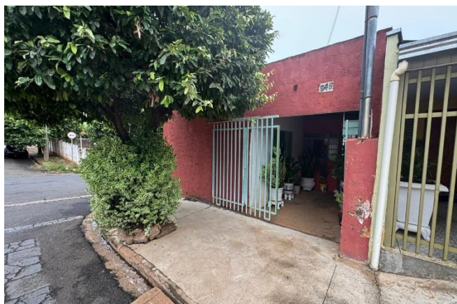
Foto 05: FACHADA DO IMÓVEL
